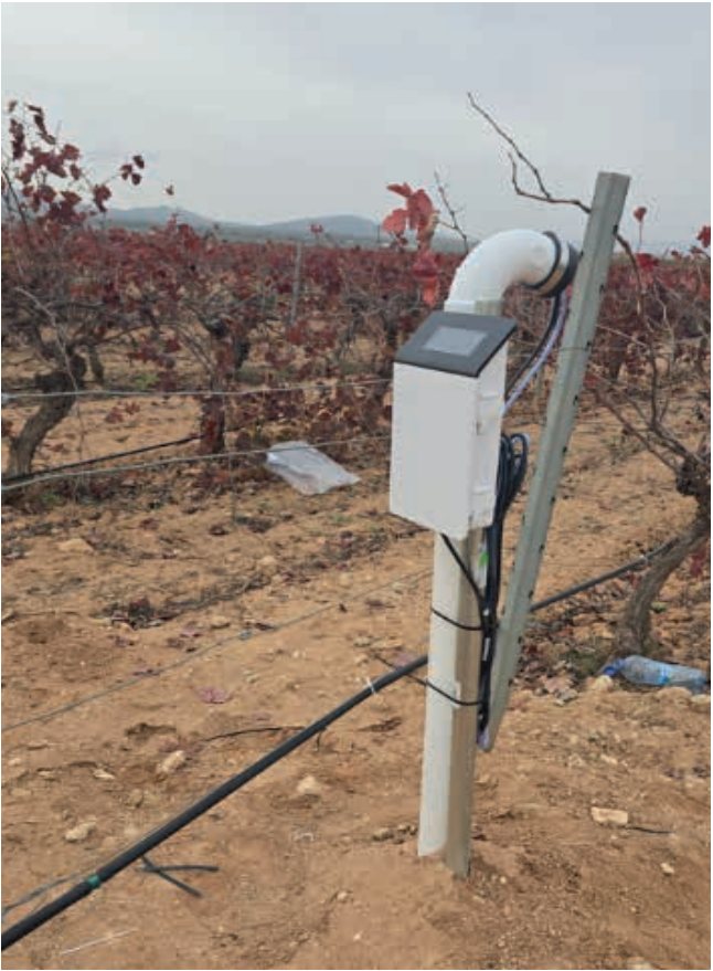
Fig 5. Lisímetro instalado en vid.
