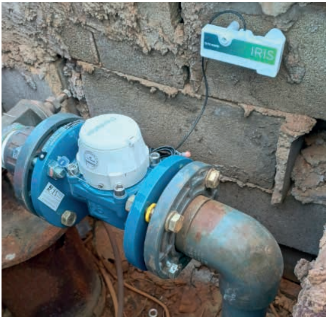
Fig 3. Contador y remota instalado en Requena.
